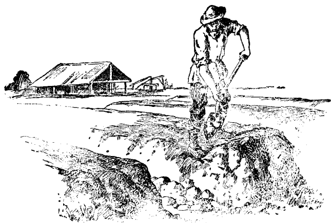
Рис. 2. Гряды подготовленной глины
