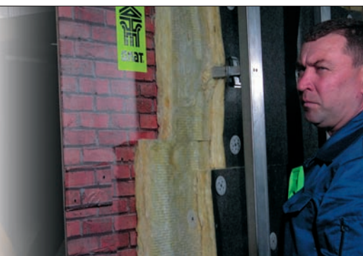
Теплоизоляционные материалы компании УРСА Евразия в системе навесных фасадов ДИАТ на демонстрационном стенде
