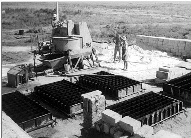
Рис. 1. Мобильный участок по производству стеновых и перегородочных блоков на объекте строительства
