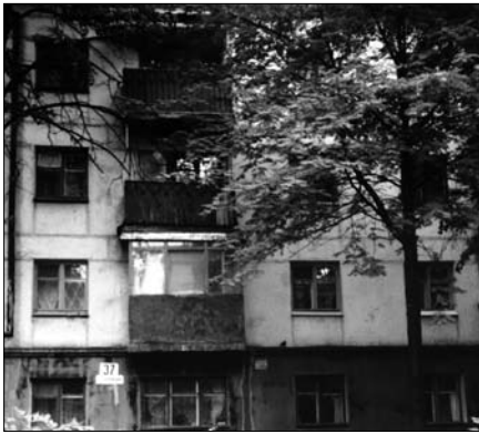
Рис. 1. Газосиликатная стена крупноблочного жилого дома (постройка 1959 г.)
