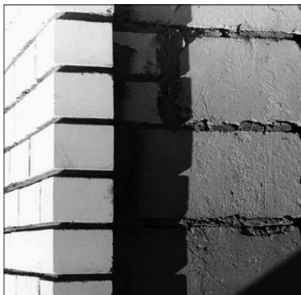
Рис. 5. Фрагмент двухслойной наружной стены газосиликат-кирпич
