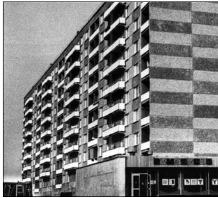
Рис. 2. Крупнопанельный жилой дом серии 1-467Д (постройка 1970 г.)
