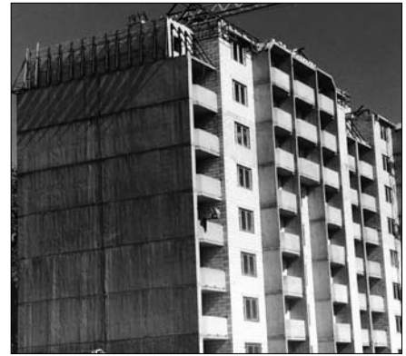
Рис. 3. Строительство дома по технологии туннельной опалубки с применением для наружных стен мелких газосиликатных блоков
