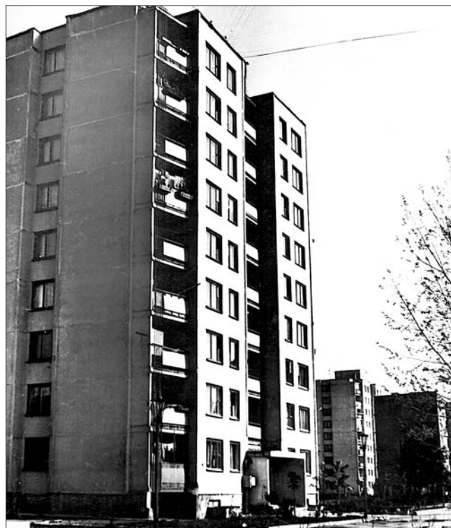
Рис. 10. Дома с газобетонными навесными панелями
