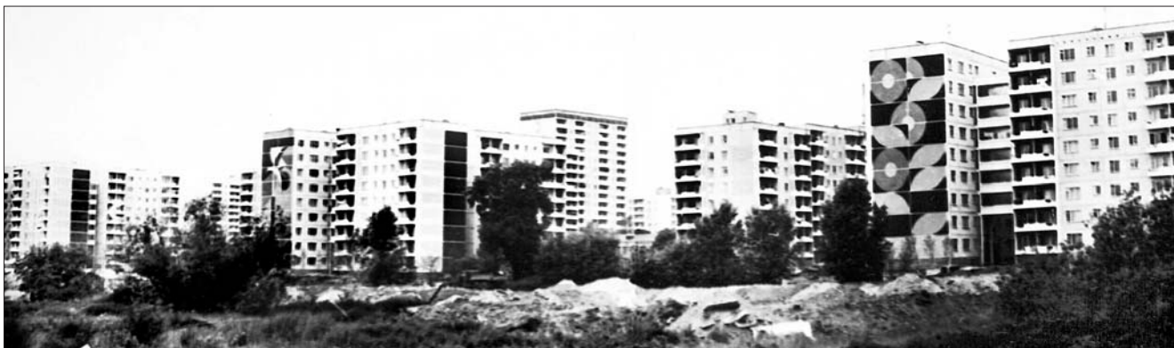
Рис. 9. Панорама застройки Екатеринбурга домами с газозолобетонными наружными стенами на два окна
