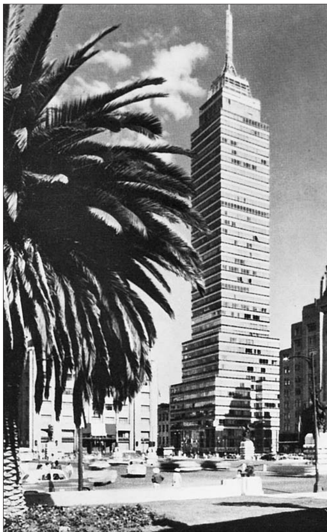
Рис. 13. 43-этажный небоскреб со стенами и перекрытиями фирмы «Сипорекс»
