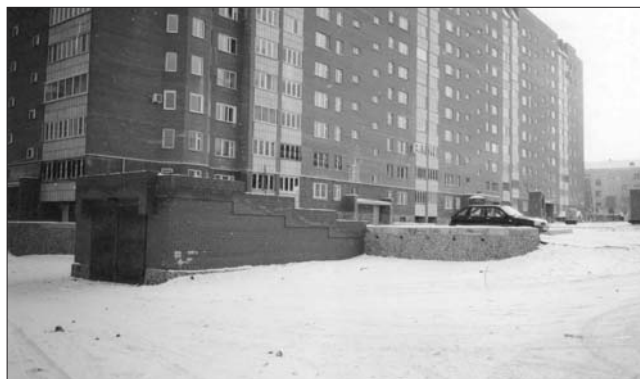
Рис. 2. Подземный паркинг (Екатеринбург, ул. Старых Большевиков)
