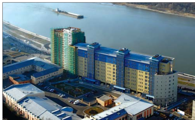
Рис. 2. Дворовый фасад здания
