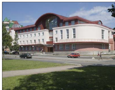
Центр социальной реабилитации, г. Пушкин, бул. Толстого, д. 25А
