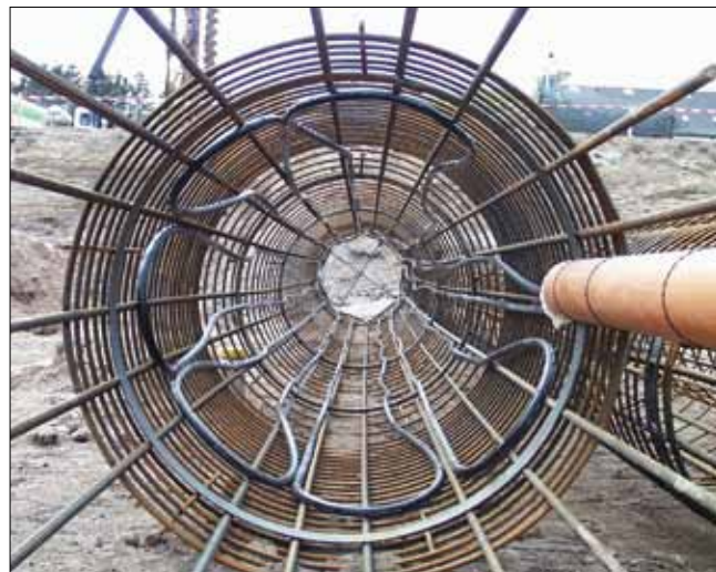
Рис. 4. Энергетическая свая
