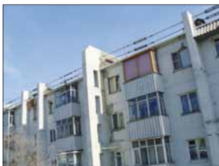
Рис. 3. Сейсмоусиление здания с помощью железобетонных конструкций и металлических тросов
