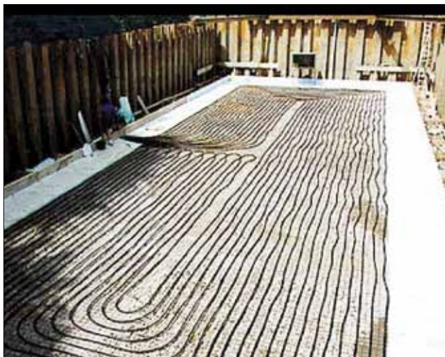
Рис. 3. Раскладка труб под фундаментной плитой
