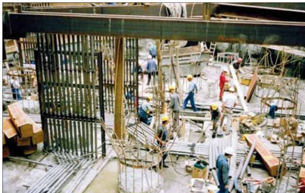
Рис. 9. Здание Майнтауэр. Современный вид и инсталляция теплообменных трубок и магистралей в уровне фундаментной плиты во время строительства
