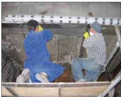
Рис. 1. Усиление балок с помощью углеткани сотрудниками ОАО «КТБ ЖБ»
