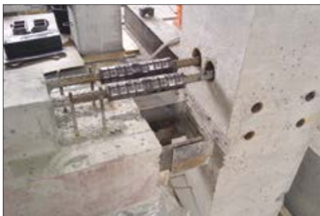
Рис. 9. Сопряжение несущих ригелей и колонны
