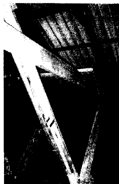
Рис. 3. Фрагмент кровли по стропильной системе из деревофанерных швеллеров
