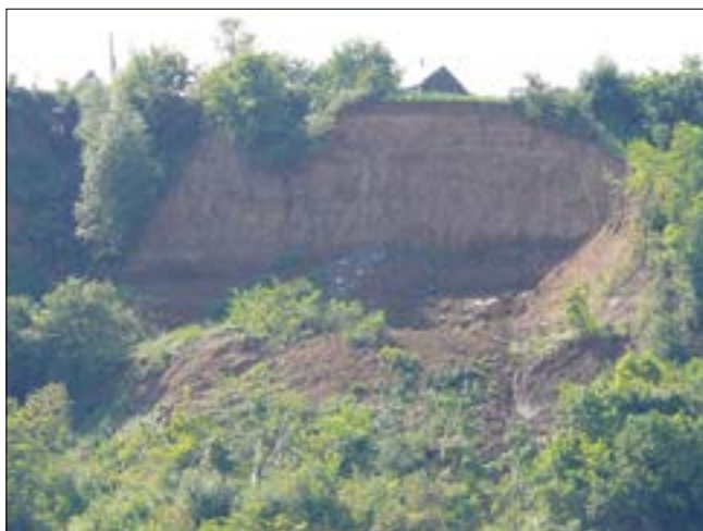
Рис. 3. Одноярусный оползень скольжения с головным блоком сброса, Новое село, г. Чебоксары
