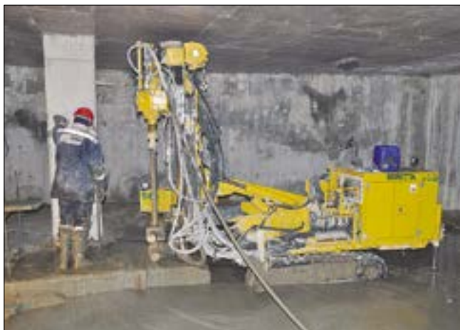
Рис. 4. Устройство грунтобетонных элементов под существующей нагруженной фундаментной плитой
