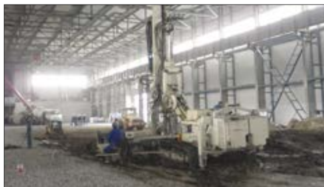
Рис. 7. Работы по устройству грунтобетонных элементов в непосредственной близости от существующих конструкций
