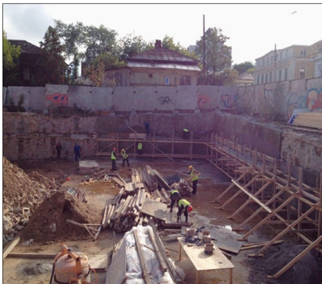
Рис. 6. Устройство подземной части здания
