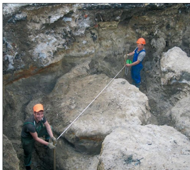
Рис. 2. Грунтоцементная колонна диаметром 3,5 м
