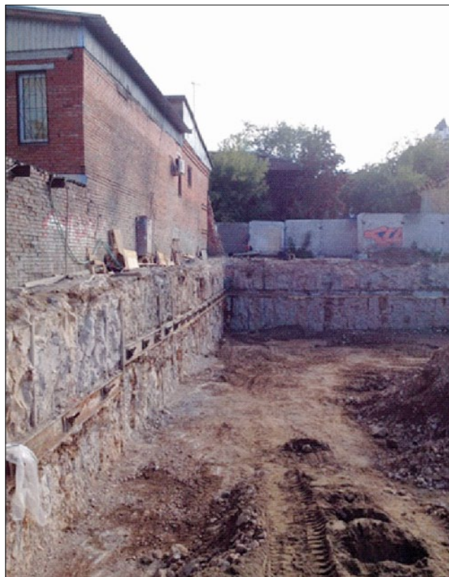
Рис. 5. Выполненное ограждение котлована
