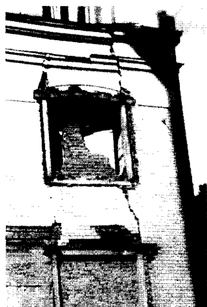
Здания в аварийном состоянии — им уже ничего не поможет
