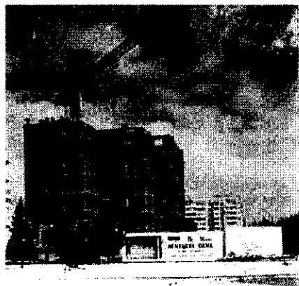
Рис. 1. Кирпичный дом в период строительства
