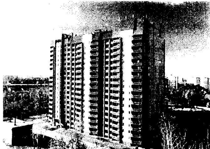
Москва, ул. Нансена. 17-этажный 6-секционный ширококорпусный жилой дом с наружными стенами из трехслойных панелей. Впервые применена автономная крышная газовая котельная
