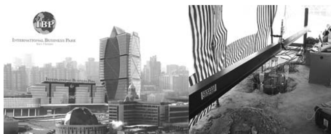
Рис. 6. Испытания свай с помощью гидравлических домкратов и с разделением свай на сегменты по системе Остенберга в Киеве
