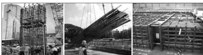
Рис. 2. Испытания баретт с помощью гидравлических домкратов и разделением сваи на сегменты
