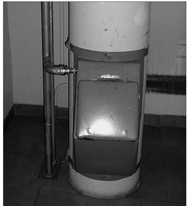
Рис. 5. Врезка магистралей в ствол мусоропровода
