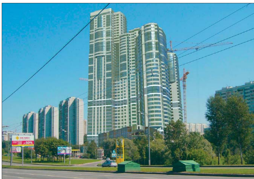
Строительство жилого дома Well-House на Ленинском проспекте, вл. 111/2 завершится в 2008 г.
