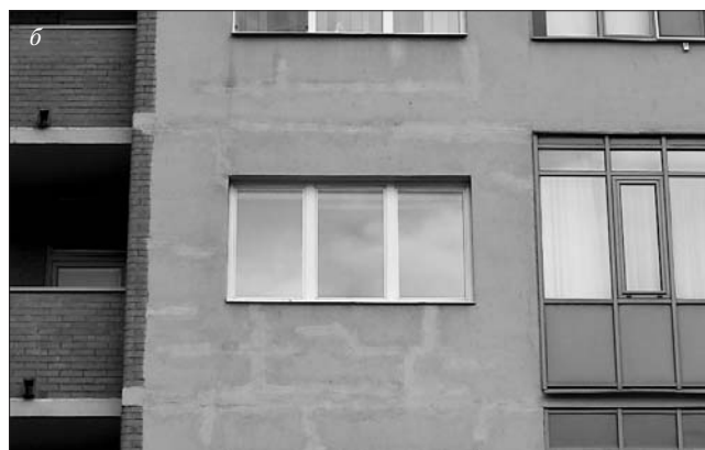
Рис. 1. Разрушение штукатурного слоя многослойной теплоизоляционной системы многоэтажного здания: а — Москва, ул. Маршала Василевского; б — Москва, ул. Архитектора Власова
