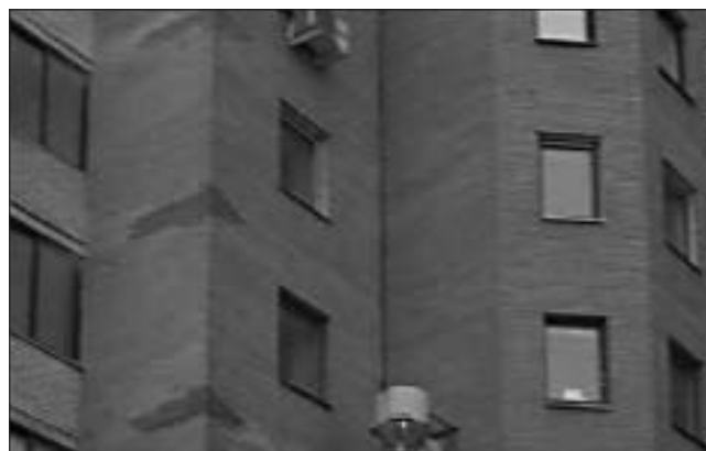
Рис. 3. Внешний вид отремонтированного облицовочного слоя из лицевого пустотелого керамического кирпича (Москва, ул. Лавочкина)
