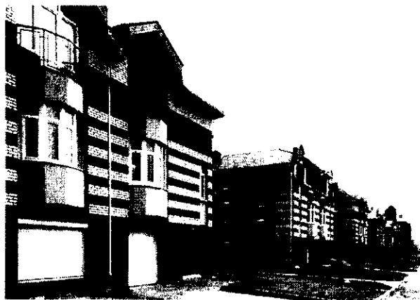
Застройка малоэтажными сблокированными жилыми домами. Коломяги, квартал 21Г. Авторы: архитекторы Ю.П.Груздев, И.С.Наймарк, конструкторы А.Н.Шерешевский, Н.М.Иванова. Строительство 1999–2001 гг.
