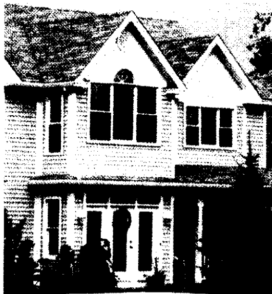
Рис. 3. Отделка фасадов сайдингом
