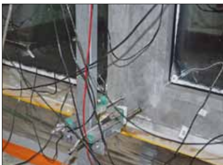
Рис. 4. Нижний участок оконного блока из профилей алюминиевых сплавов при t_{н} = -50^\circ\text{C}
