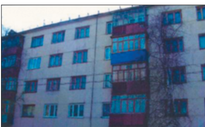
Рис. 1. Жилой дом, г. Нефтеюганск, 3-й мкр., д. 1
