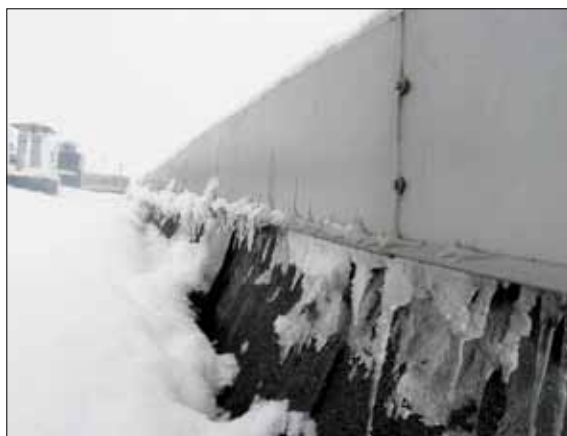
Рис. 6. Образование наледи на наружной поверхности вентилируемого фасада здания бассейна из-за неудовлетворительного технического состояния пароизоляции стены
