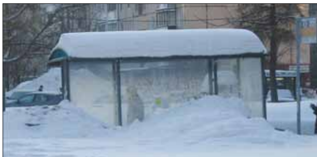
Рис. 1. Пример отсутствия наледей на крыше открытого павильона остановки общественного транспорта
