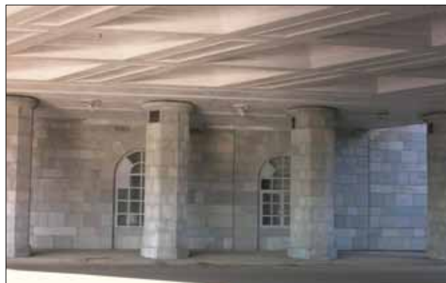
Рис. 3. Применение лакокрасочных материалов на Краснохолмском мосту
