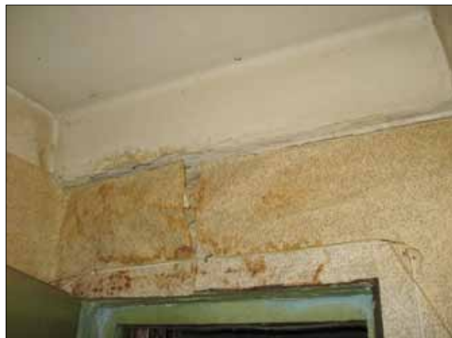
Рис. 8. Примеры образования конденсата на конструкциях технического холодного этажа, но с остекленными продухами, и выпадения «осадков» в квартире, расположенной ниже
