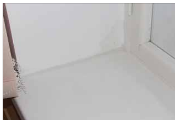
Рис. 4. Термограмма и общий вид участка образования конденсата и плесени на поверхности откоса проема в месте дефекта теплоизоляции
