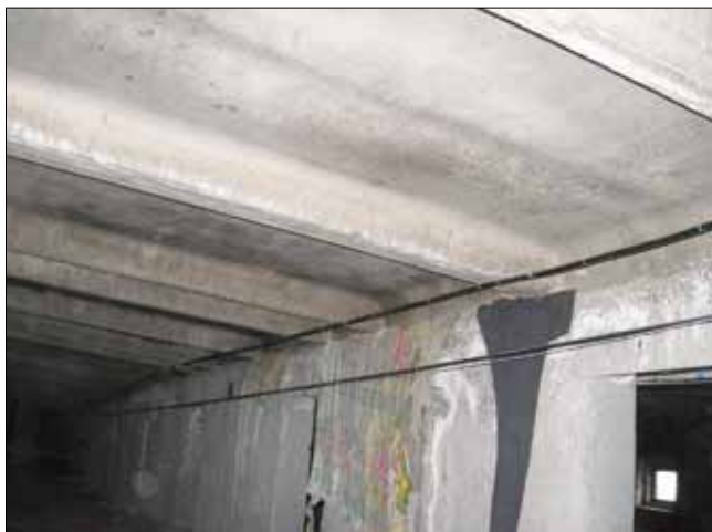
Рис. 8. Примеры образования конденсата на конструкциях технического холодного этажа, но с остекленными продухами, и выпадения «осадков» в квартире, расположенной ниже
