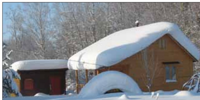
Рис. 2. Пример отсутствия наледей на крыше неотапливаемого дачного дома
