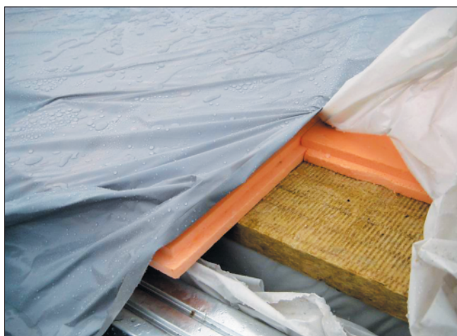
Рис. 2. Укладка комбинированной кровли на объекте в Санкт-Петербурге
