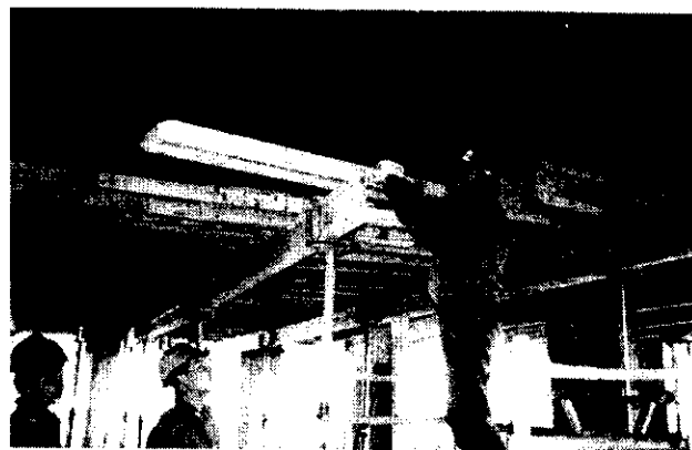
Демонтаж опалубки перекрытия (бригада А.И.Котова)
