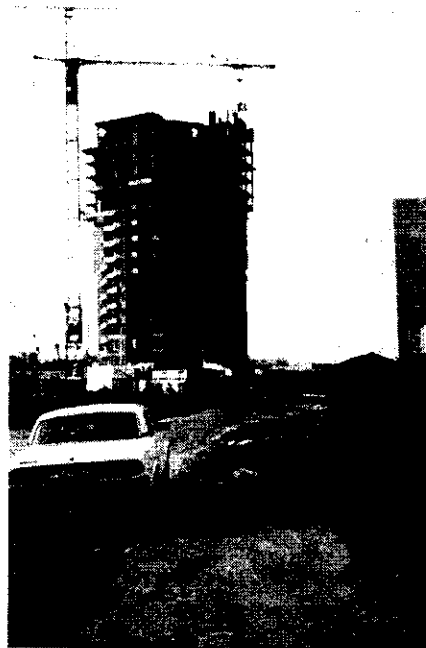
Строительство 17-этажного жилого дома (г. Люберцы, городок "Б")
