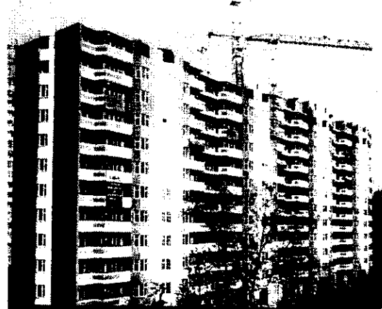
Строится дом суперсерии П44ТМ
