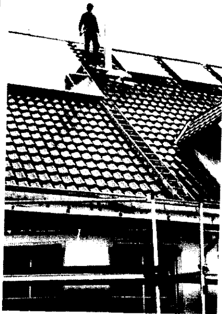
Установка солнечных батарей на крыше
