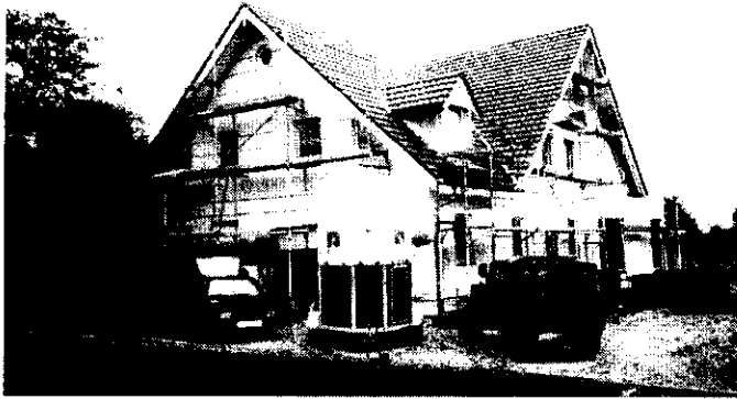
Энергосберегающий дом в процессе строительства
