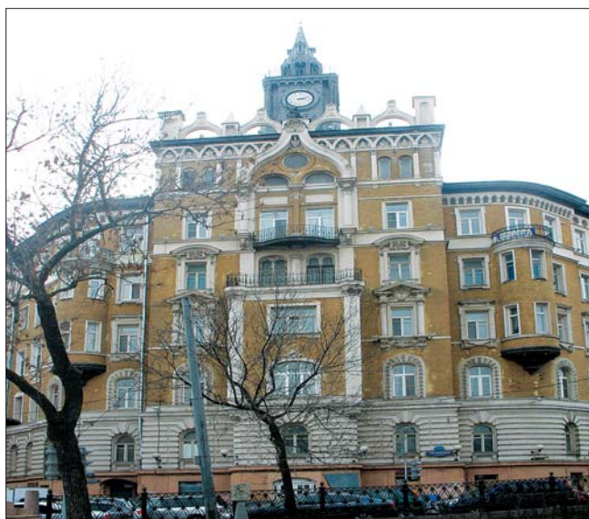
Рис. 8. Жилой комплекс страхового общества «Россия», построен в 1899–1902 гг., арх. Н.М. Проскурин и А.И. фон Гоген (Москва, Сретенский бульвар, 6/1)
