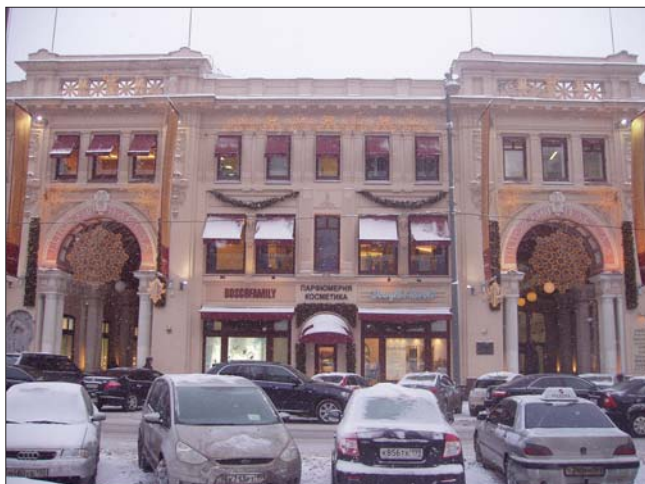
Рис. 9. Фасад Петровского пассажа по ул. Петровка
