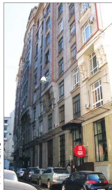
Рис. 9. Дом коридорного типа для одиноких служащих, деловых людей и малых семей, так называемый «дом холостяков». Построен в 1914 г., арх. Э.-Р.К. Нирнзее (Москва, Б. Гнездиковский пер., 10)
