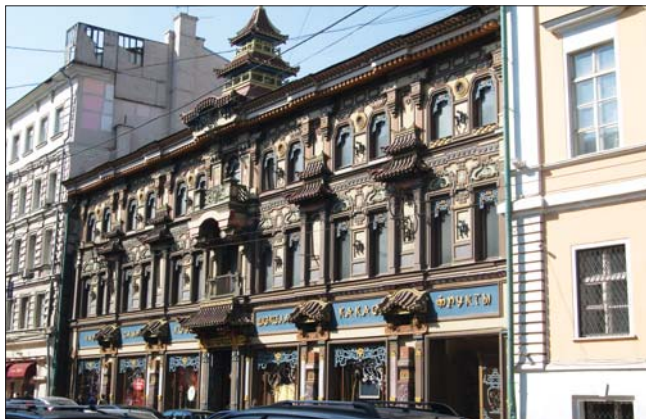
Рис. 4. Доходный дом В.Д. Перлова, единственная в Москве постройка в китайском стиле (Москва, ул. Мясницкая, 19). Построен в 1890–93 гг. по проекту Р.И. Клейна; в 1895 г. выполнен декор фасада по проекту арх. К.К. Гиппюса. На первом этаже до сих пор располагается знаменитый чайный магазин
