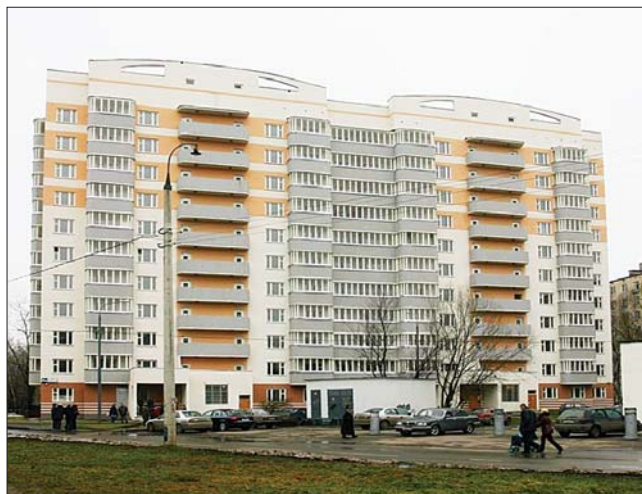
Рис. 6. Многоэтажный жилой дом (Москва, ул. Палехская)
