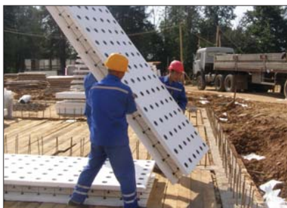
Рис. 1. Установка опалубки без использования подъемных механизмов
