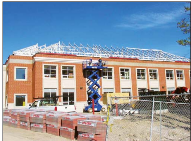
Рис. 3. Возведение мансарды в существующем здании
