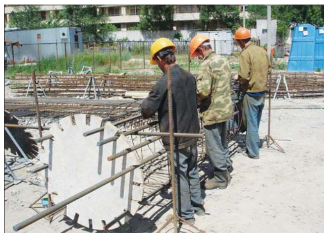
Рис. 1. Изготовление каркаса на стройке
