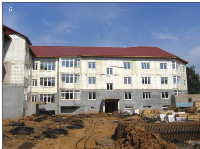
Рис. 4. Многоквартирный трехэтажный жилой дом с цокольным этажом в пос. Первомайское (Московская обл.): а – строительство по технологии PLASTBAU®; б – готовый дом
