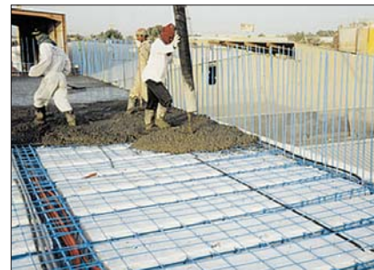
Рис. 3. Заливка бетона полностью готового этажа
