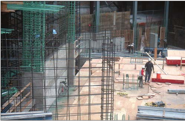
Рис. 2. Использование готовых каркасов на строительной площадке
