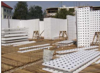
Рис. 2. Смонтированная по проекту стеновая опалубка
