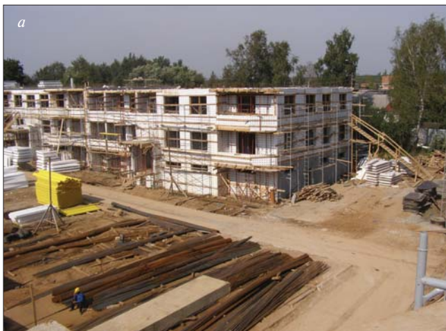
Рис. 4. Многоквартирный трехэтажный жилой дом с цокольным этажом в пос. Первомайское (Московская обл.): а – строительство по технологии PLASTBAU®; б – готовый дом
