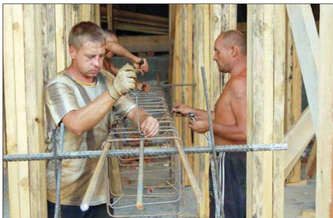
Рис. 3. Кустарное изготовление каркаса на строительной площадке
