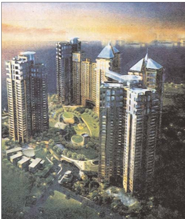
Рис. 3. Многоэтажный жилой комплекс в Пномпене
