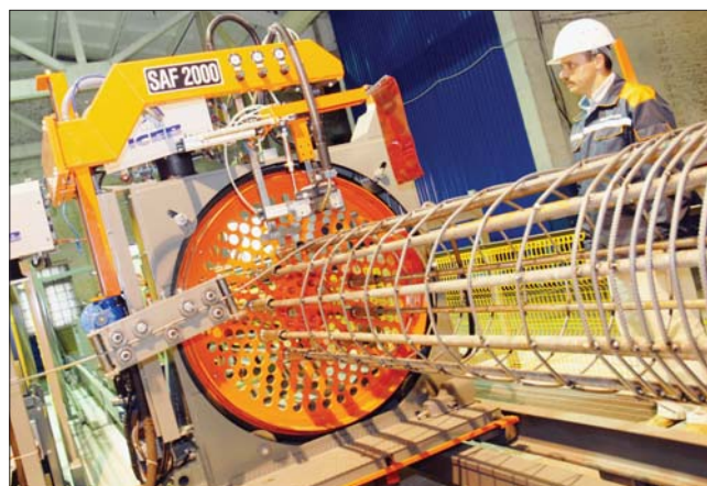
Рис. 2. Изготовление каркаса в ОАО «ИНПРОМ»
