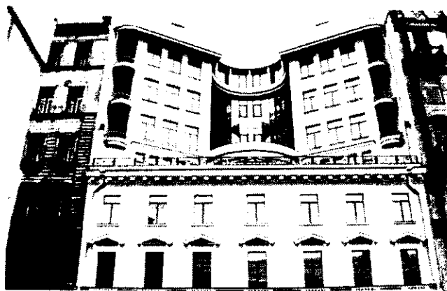
Гангутская улица, 8. Элитный жилой дом. Архитекторы В.А.Реппо, Т.В.Васильева
