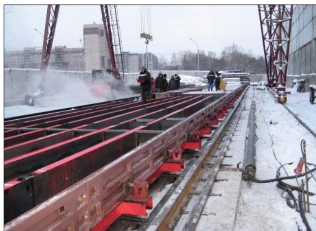
Рис. 4. Реконструкция завода ЖБИ в Красноярске под выпуск современных железобетонных конструкций для строительства жилых домов мощностью 250 тыс. м 2 /год
