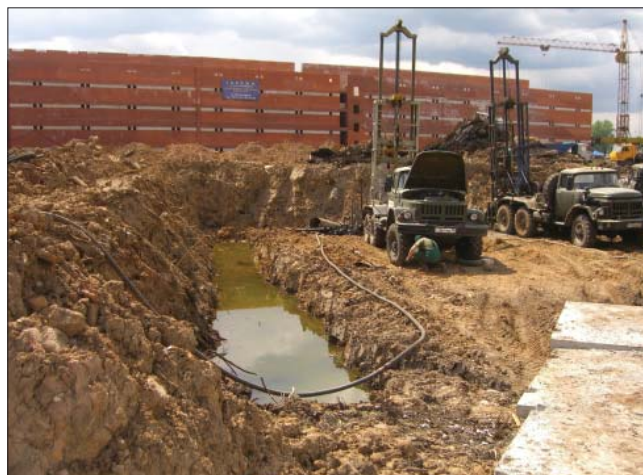
Рис. 3. Бурение лидерных скважин буровыми установками ЛБУ-50 и заполнение скважин раствором
