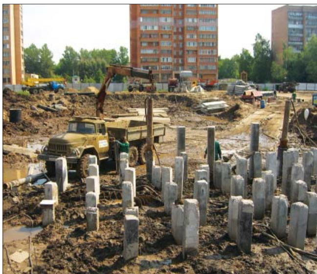
Рис. 4. Погружение свай пневмопробойниками СО-166 в предварительно пробуренные скважины с раствором
