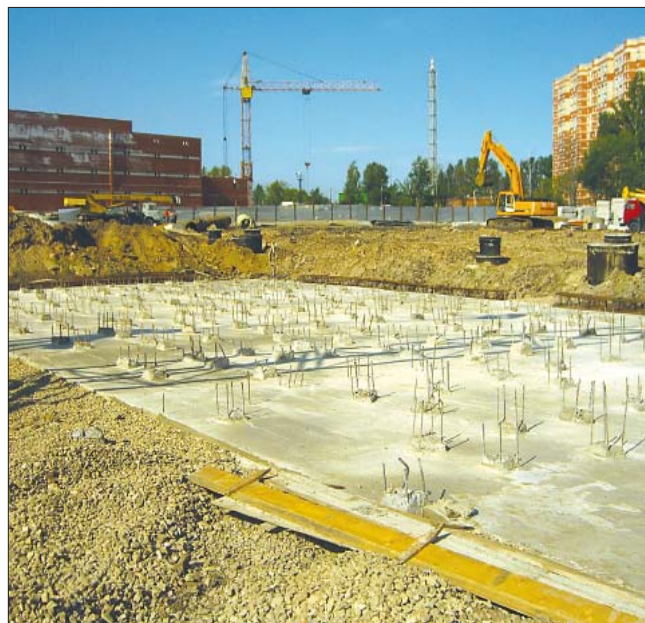
Рис. 9. Основание фундаментной плиты крупнопанельного здания на сваях
