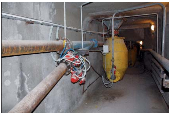
Рис. 7. Подсилосная галерея склада цемента
