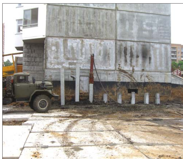
Рис. 5. Работа пневмопробойника СО-166 вплотную к жилому зданию не вызвала его дополнительных деформаций
