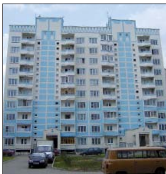
Рис. 5. Крупнопанельный жилой дом в микрорайоне Давыдовский-3 в Костроме. 2008 г.
