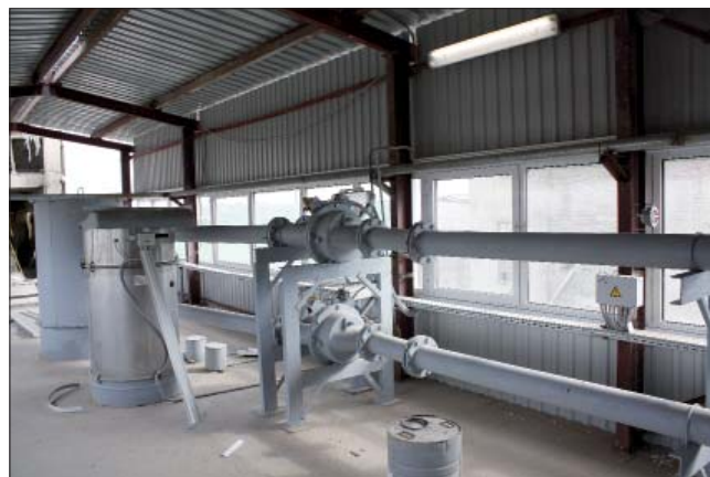
Рис. 8. Надсилосная галерея склада цемента
