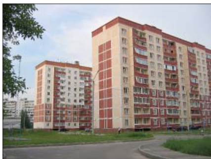
Рис. 8. Крупнопанельные жилые дома по ул. Западной в г. Электросталь (Московская обл.). 2005 г.
