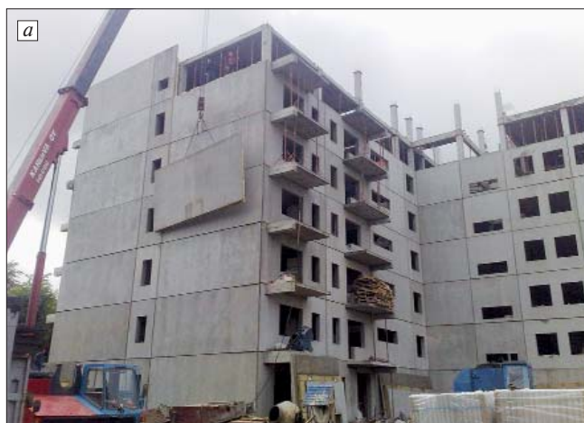
Рис. 1. Возведение социального жилого дома в Санкт-Петербурге: а – монтаж навесных трехслойных панелей на сборно-монолитный каркас; б – окончательная отделка фасадов
