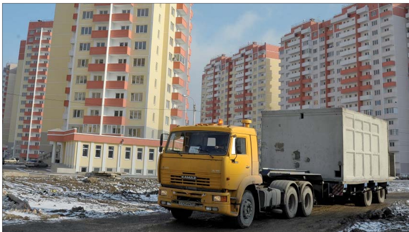
Рис. 1. Доставка объемного блока на строительную площадку жилой застройки (Краснодар, ул. Восточно-Кругликовская)
