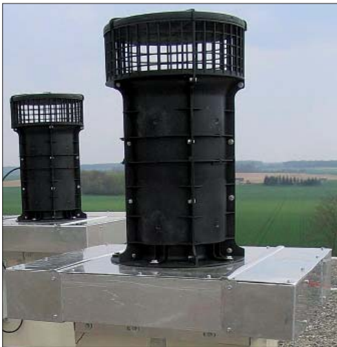
Рис. 3. Гибридный вентилятор на каналах естественной вытяжки
