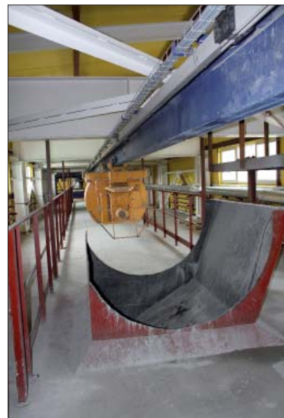
Рис. 6. Современная система адресной доставки бетона
