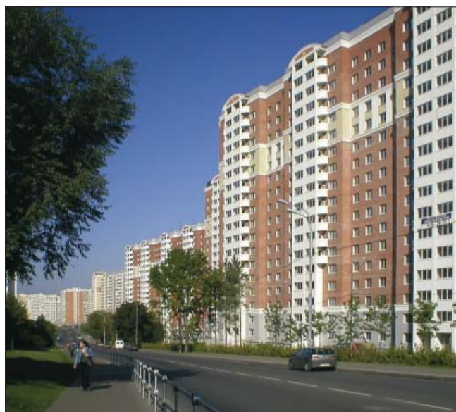
Рис. 3. Жилые дома серии 222 с наружными стенами из мелкоштучных элементов для строительства в Москве и Московской области. ЦНИИЭП жилища
