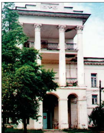
Рис. 6. Центральный ризалит главного фасада дома Расторгуевых
