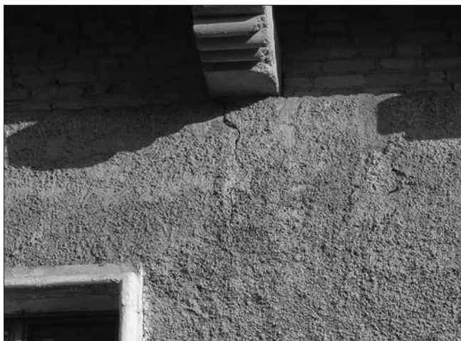
Рис. 4. Осадочные трещины в наружных стенах зданий
