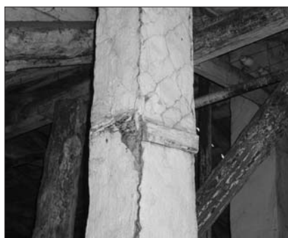
Рис. 7. Разрушение вентиляционных каналов
