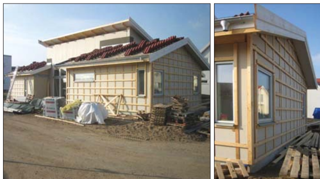
Применение фасадных КНАУФ-листов в каркасном домостроении в Германии
