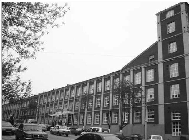
Иваново. Офисно-деловой комплекс «Дербенев-центр» в корпусах бывшей фабрики имени Кирова. Внешний вид. Реновация 2003 г.
