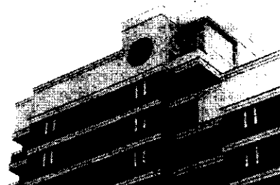
Фрагмент южного фасада
