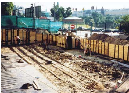
Рис. 9. Устройство опалубки по грунту и армирование плиты перекрытия
