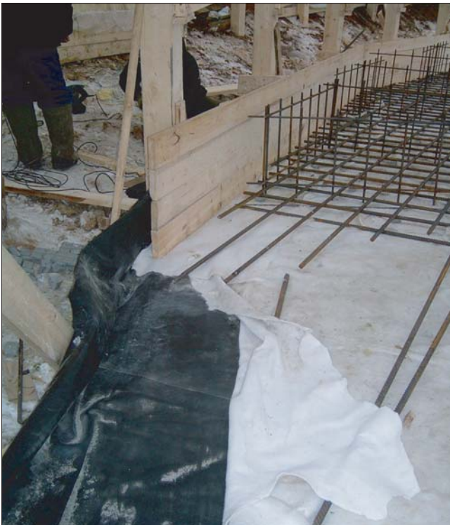
Рис. 1. Фрагмент бетонного фундамента со слоем ЭПИКРОМа перед заливкой
