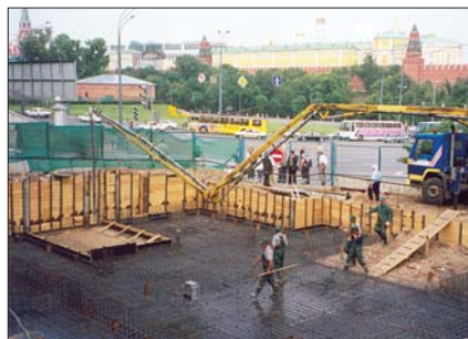
Рис. 10. Бетонирование плиты перекрытия
