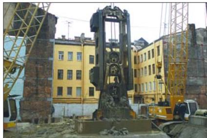
Рис. 3. Устройство стены в грунте при создании подземного объема комплекса Stockmann на Невском проспекте
