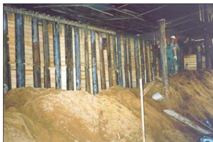
Рис. 13. Разработка бермы около стен и монтаж забирки
