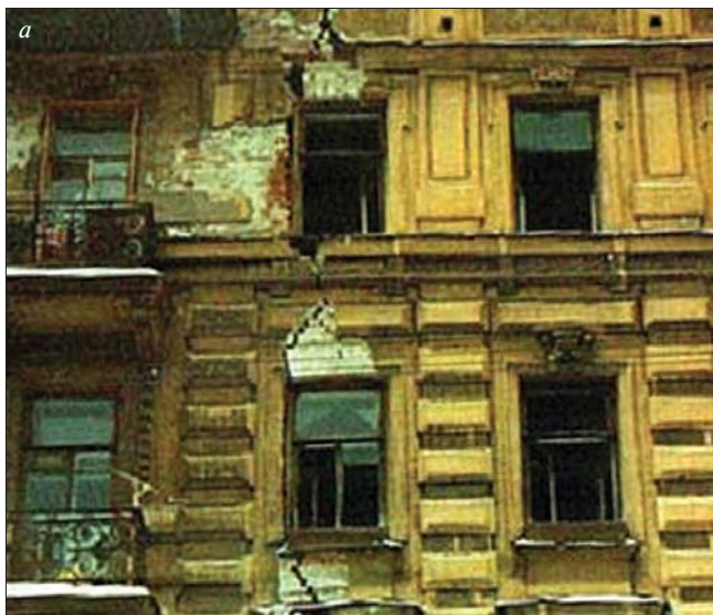
Рис. 1. Осадка существующего здания (Санкт-Петербург, ул. М. Дворянская, д. 6) при устройстве ограждения котлована из буронабивных свай под защитой осадных труб: а – общий вид; б – осадка 3-этажной (1) и 5-этажной (2) частей
