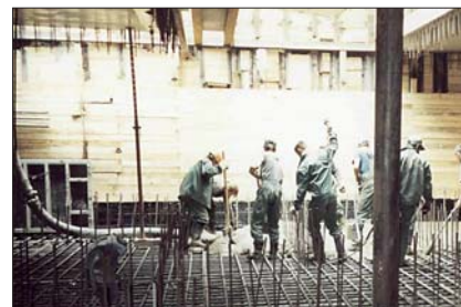
Рис. 14. Бетонирование фундаментной плиты
