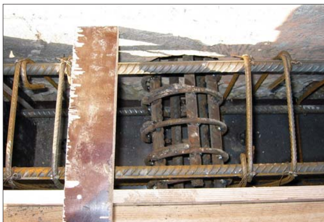
Рис. 3. Армирование обвязочного пояса
