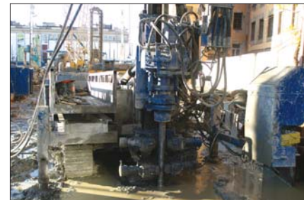
Рис. 4. Устройство распорной диафрагмы методом jet grouting
