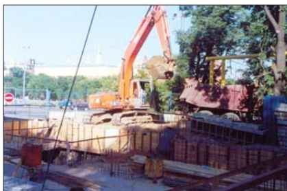
Рис. 12. Подъем грунта экскаватором Hitachi и погрузка на автомобили
