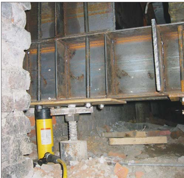
Рис. 6. Включение свай усиления в работу путем их поддомкрачивания
