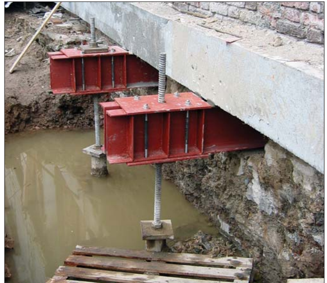
Рис. 5. Конструкция передачи нагрузки на сваи усиления
