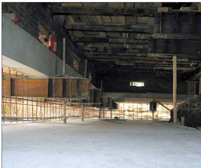
Рис. 9. Вид плиты на отм. -2,0
