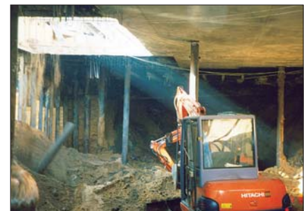
Рис. 11. Разработка грунта под плитой экскаваторами Hitachi EX 30
