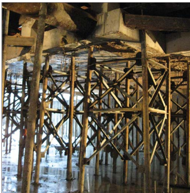
Рис 14. Устройство подземного пространства под театром
