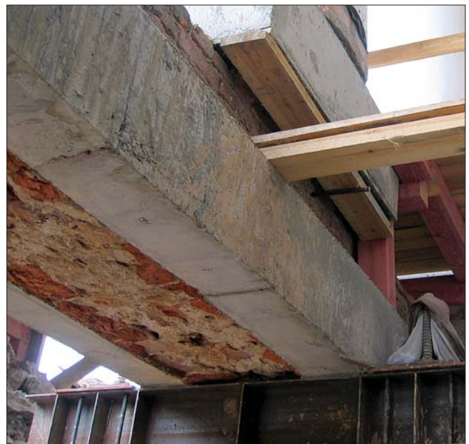
Рис. 7. Этап разборки старых фундаментов ниже обвязочного пояса
