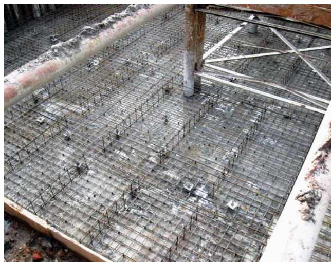
Рис. 13. Армирование плиты на отм. -6,0
