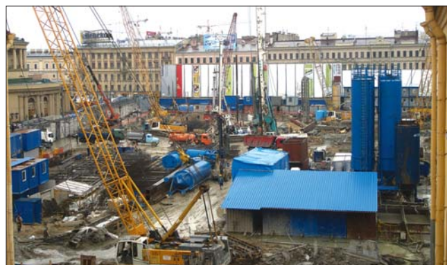
Рис. 2. Общий вид строительной площадки торгово-офисного комплекса Stockmann
