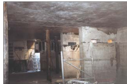
Рис. 17. Стены подвала с нишами для виброизоляторов
