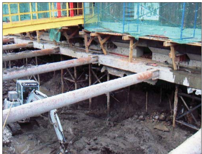
Рис. 11. Откопка котлована до отм. -6,0 с предварительным устройством распорной системы и подкосов по сваи усиления
