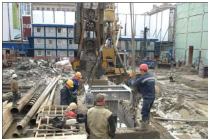
Рис. 3. Устройство стены в грунте при создании подземного объема комплекса Stockmann на Невском проспекте
