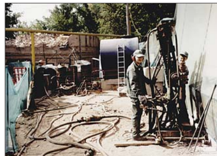
Рис. 5. Смолизация грунта основания
