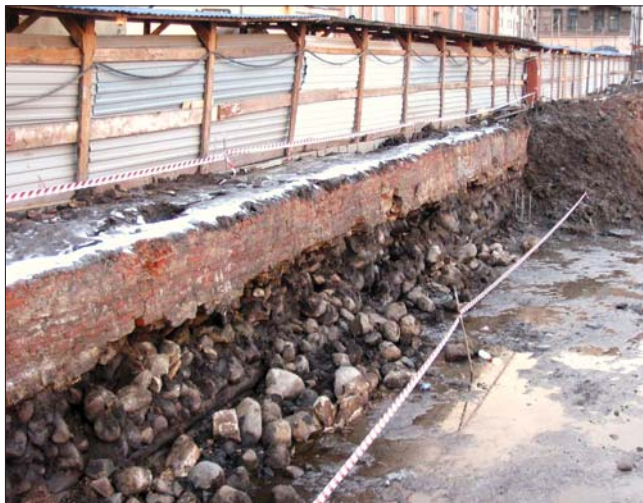
Рис. 1. Вид вскрытого бутового фундамента с деревянными лежнями
