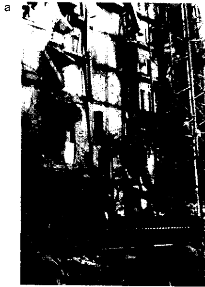
Рис. 2. 9-этажный кирпичный дом с поперечными несущими стенами на Щербакоской ул. в Москве после обрушения отсека в результате взрыва а — фрагмент фасада; б — угол дома с вертикальной трещиной
