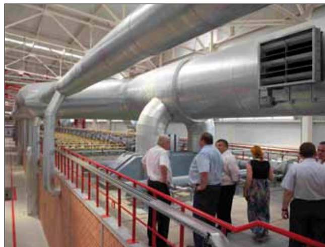
Фрагмент установки сводовых горелок на туннельной печи
