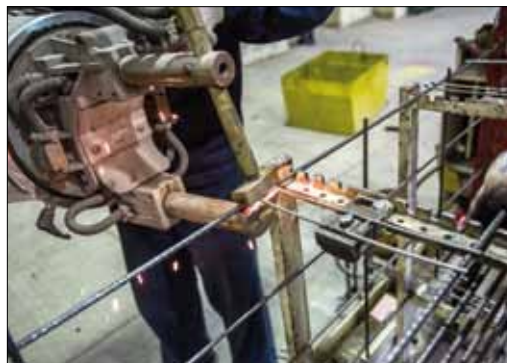
Изготовление арматурных каркасов
