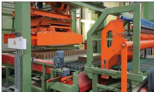
Многострунный резчик и грейфер садки сырца на рамки сушильной вагонетки на заводе «ГрозСтройКерам»
