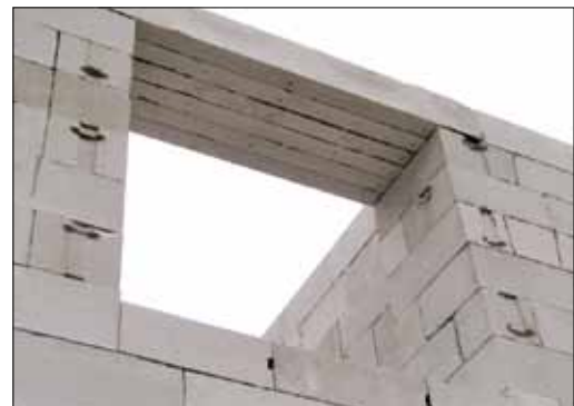
Армированные перемычки из автоклавного газобетона использованы при оформлении оконного проема
