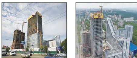
Рис. 3. Здание «Идель-Тауэр»: завершается возведение монолитного каркаса (лето 2017 г.)
