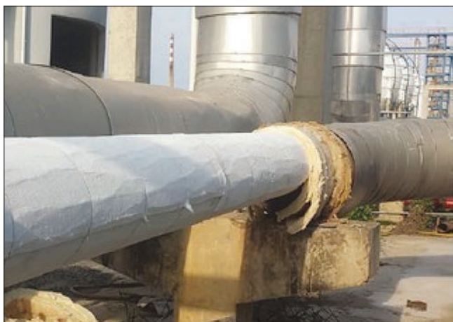
Рис. 1. Примеры использования рулонных материалов на основе аэрогеля для тепловой изоляции оборудования и трубопроводов Fig. 1. Application of aerogel-based rolled materials for heat insulation of equipment and pipelines
