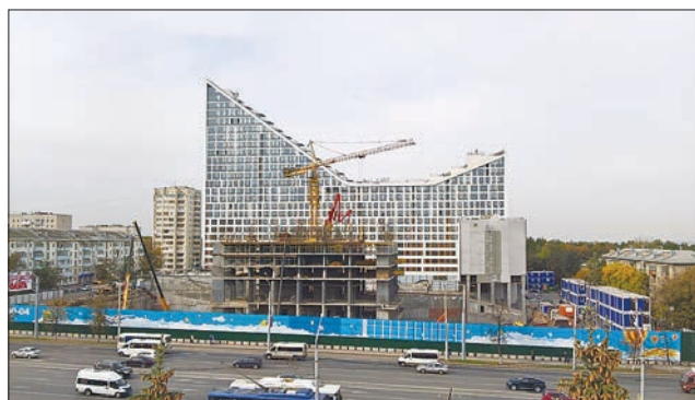
Рис. 2. Здание «Идель-Тауэр». Построено три надземных этажа (сентябрь 2016 г.)
